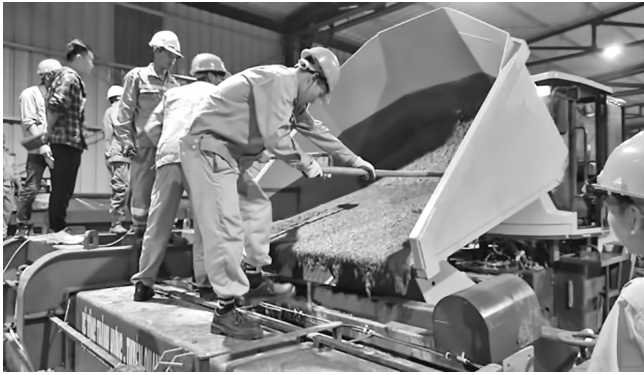
Hình 5. Thi công UHPC tại dự án sửa chữa mặt cầu Thăng Long
